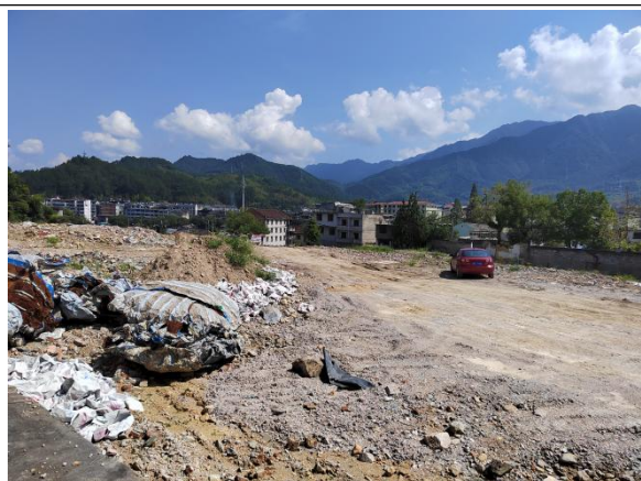
地块内东北角，现状已拆除相关建筑
