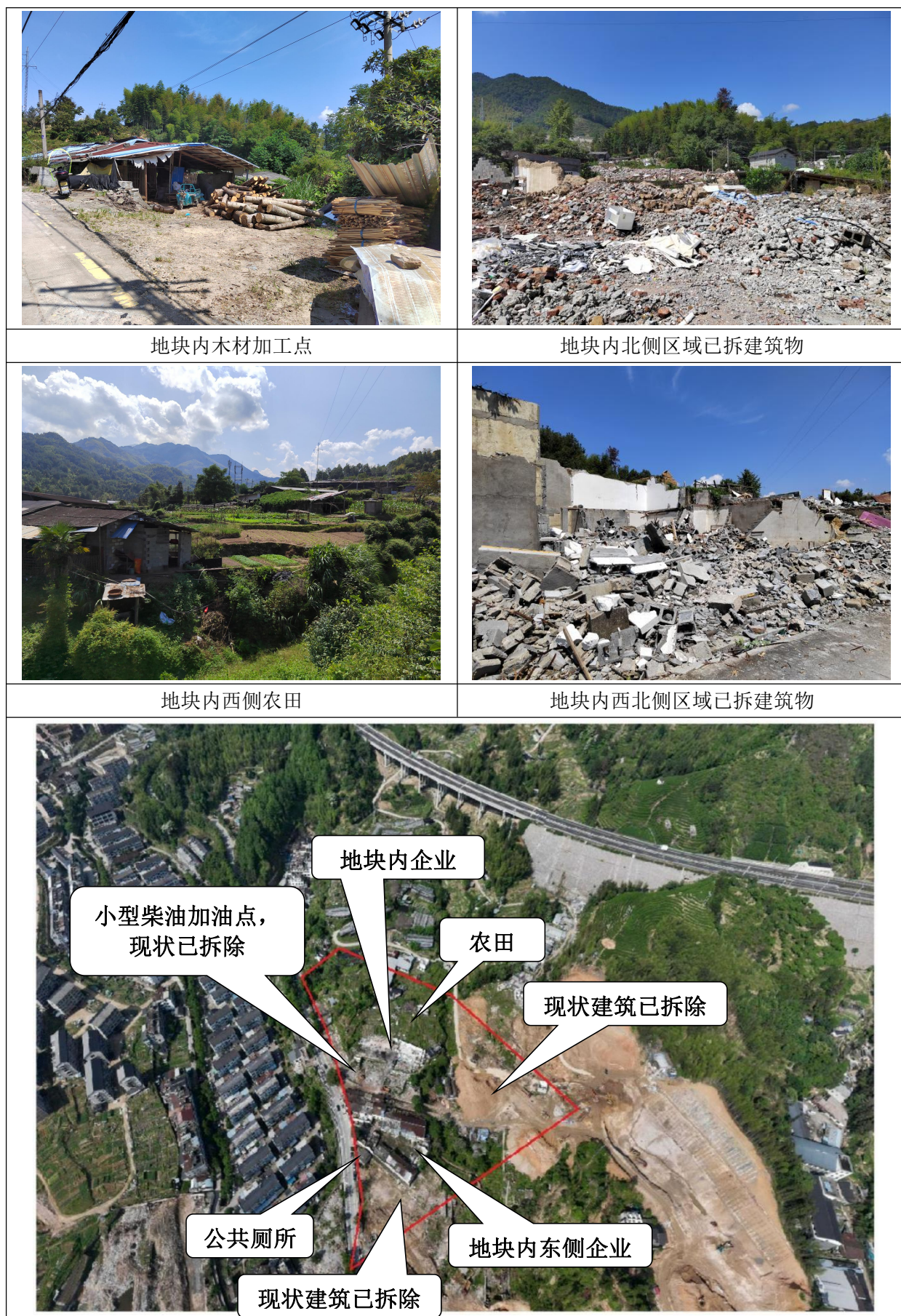
图 3.4-1 地块现状照片图
