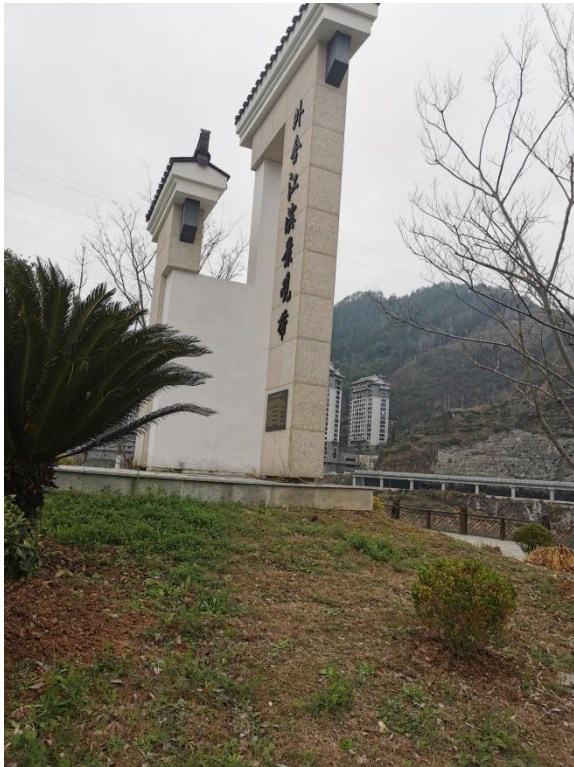
附图3 项目现场照片
